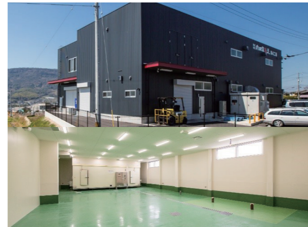
【図3】本事業による設備は、新工場に設置された
