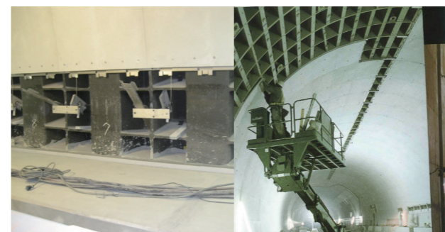
【図2】トンネル耐火板取付け
