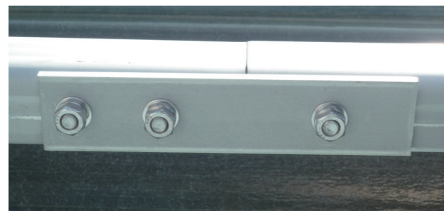
【図 1】従来の部材接合状況
