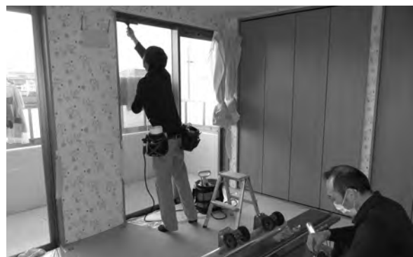
▲窓ガラスに飛散防止フィルムを貼り付ける
