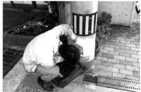
▲撤去作業の様子
