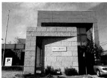
丸亀オフィス
