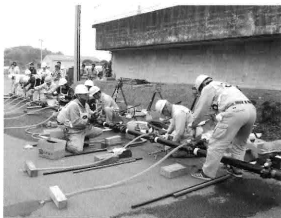
▲配管講習風景
