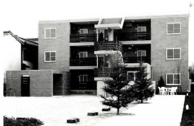
▲施工事例(マンション)
