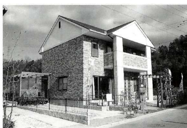
▲施工事例(TADホーム)
